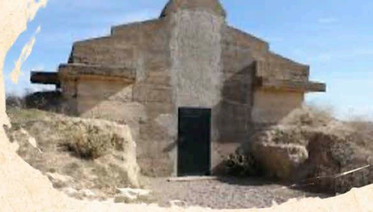
Cubierta y entrada de acceso al Tholos de la Pastora
